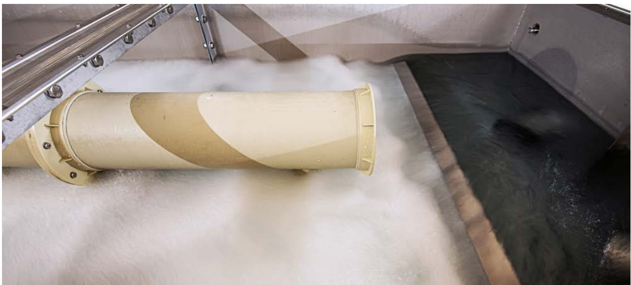
Abbildung 4: Trinkwasseraufbereitung – physikalische Entsäuerung (Quelle: Stadt Groß-Umstadt)
